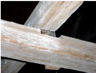
Kæmning mellem hanebånd og drager udført med forsats.
