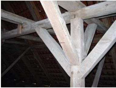
Stolpekonstruktionen er udført af 6 x 6" savskåret fyr.
