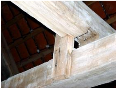
Oprettning af stolpekonstruktionen har ikke været tilstrækkelig
