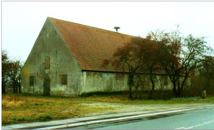
Krudthus 2 på Bachermindevej 1, Dragør.
